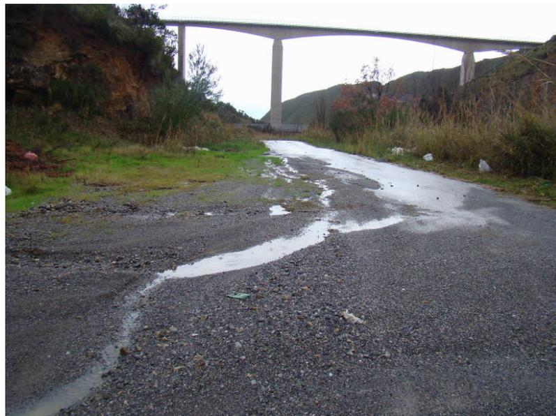
Per una sistemazione definitiva del versante sono necessari ulteriori interventi sulla sinistra idrografica del torrente, quali gabbioni e modeste opere di ingegneria naturalistica, quali viminate o graticciate per impedire l'erosione al piede e sul versante.
